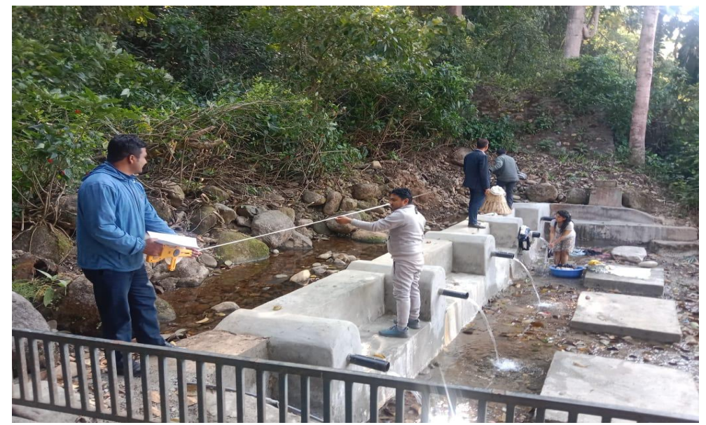
खानेपानी धारा संरक्षण तथा मर्मत
