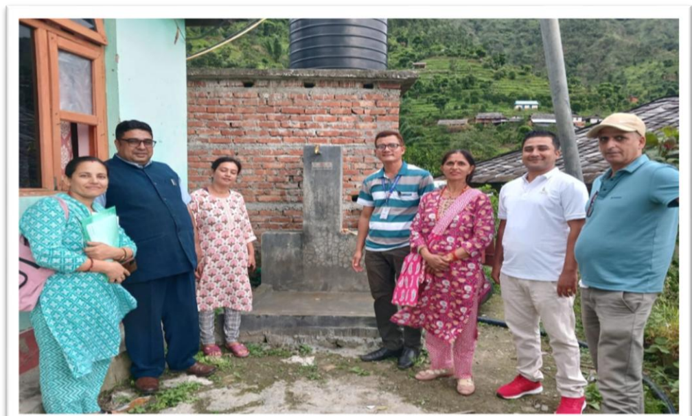
खानेपानी ट्यांकी तथा धारा निर्माण
